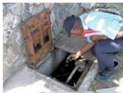
Fig. 6 : chambre de raccordement du réseau téléphonique
