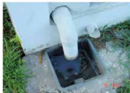
Fig. 5 : regard d'eau pluvial
