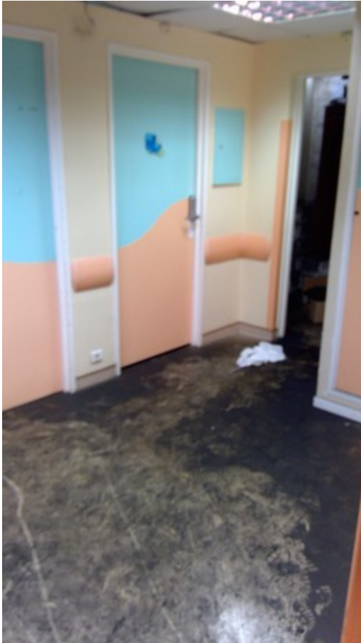
Figure 25 : Présence de suies dans le service de la Maternité
