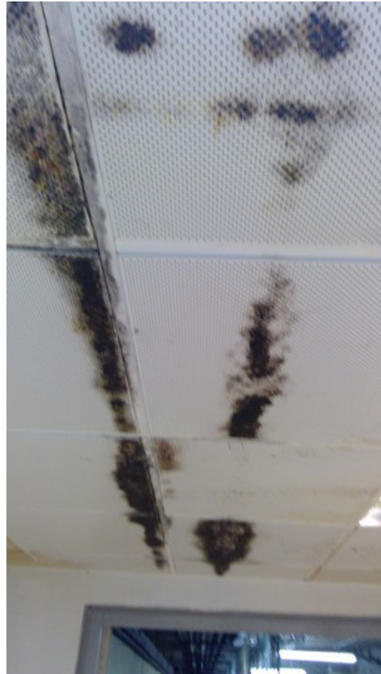
Figure 35 : Moisissures et rouilles dans les dalles de faux plafond
