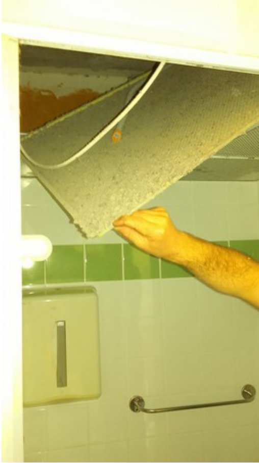
Figure 29 : Encrassement d'une bouche d'extraction
