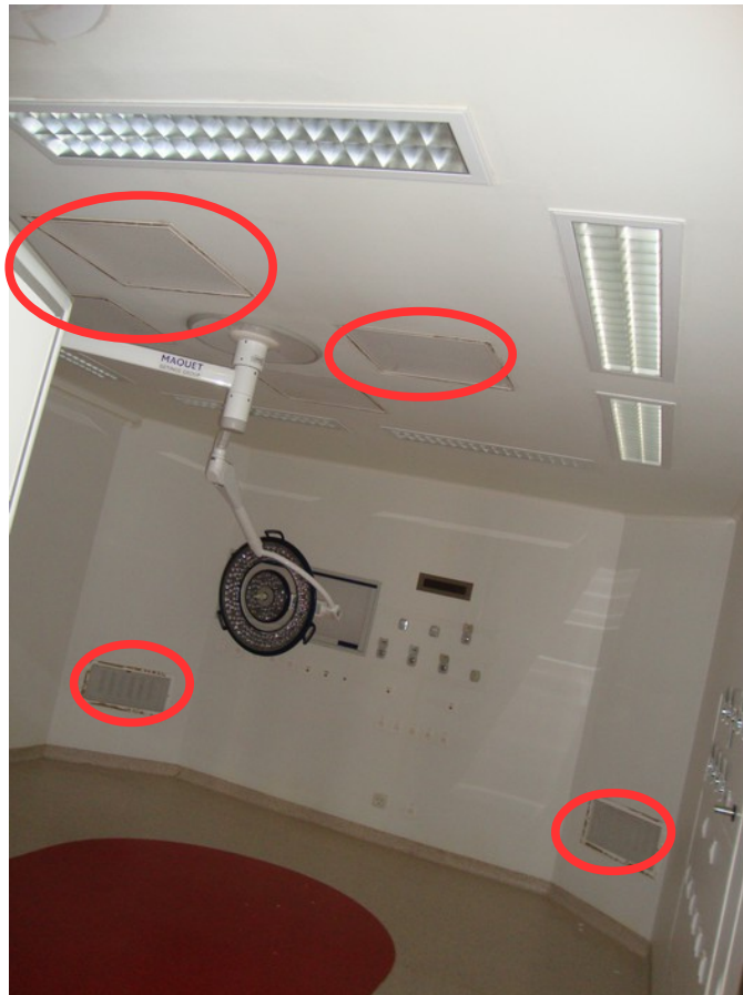
Figure 24 : Bloc Obstétrique décontaminé avec les bouches de ventilation bâchés (entourées en rouge)
