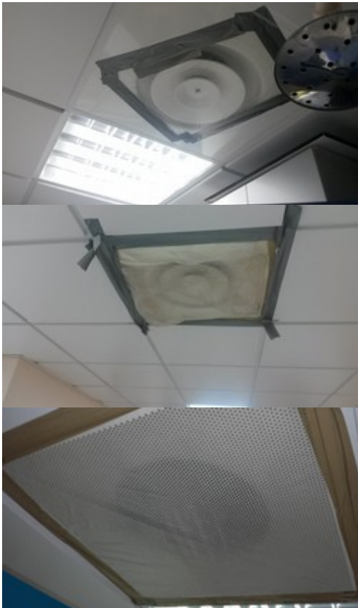
Figure 31 : Dispositifs de calfeutrement des bouches de soufflage et de reprise d'air
