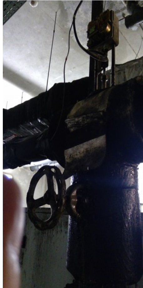
Figure 34 : État des canalisations du réseau d'eau glacée
