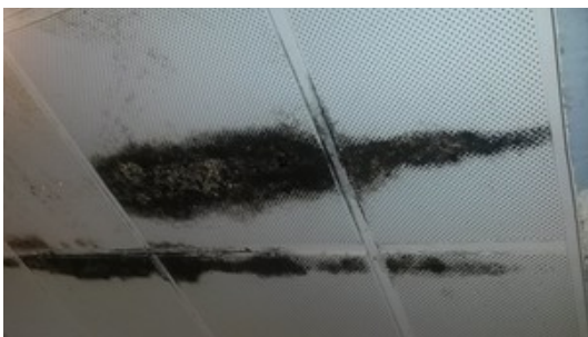
Figure 36 : Moisissures dans les dalles de faux plafond
