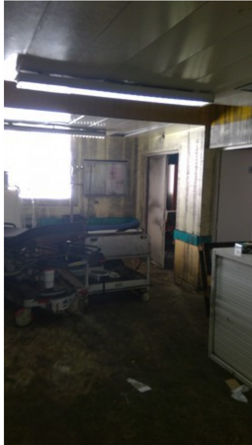
Figure 26 : Présence de suies dans le service de la Maternité
