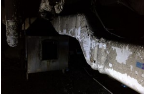
Figure 4 : Anciennes gaines qui n'ont pas été déposées avant l'incendie
