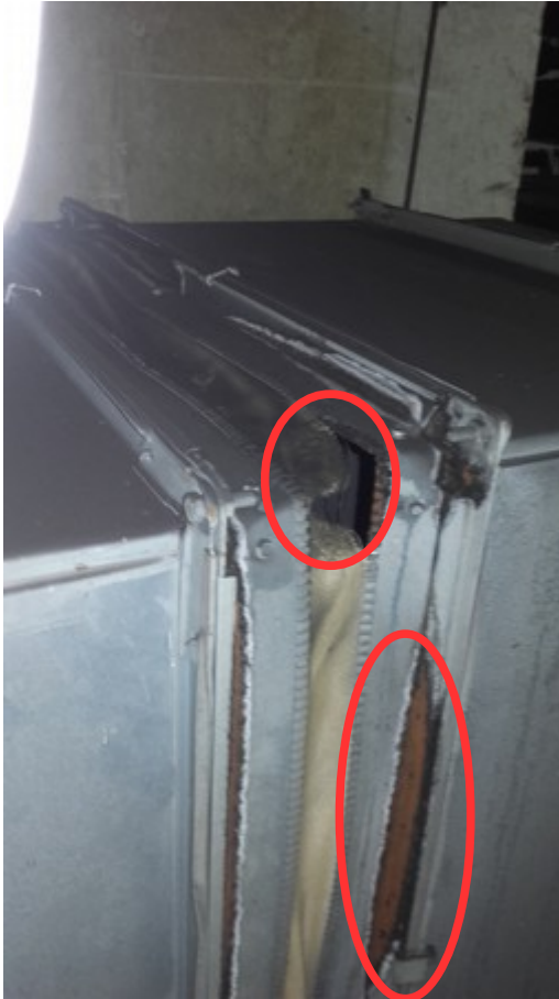
Figure 21 : Raccordement entre la manchette souple du raccordement CTA BA /gaine de ventilation percée
