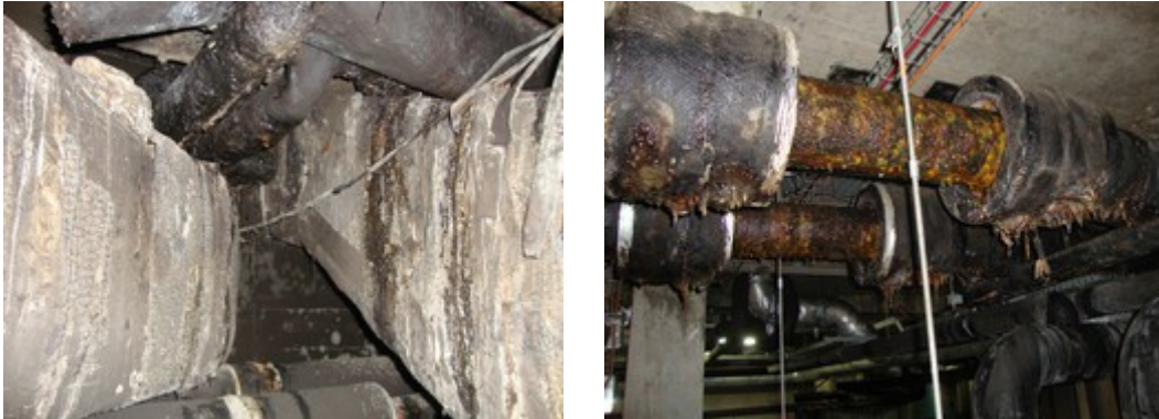
Figure 8 : État dégradé des réseaux aérauliques et e production et de distribution d'eau glacée
