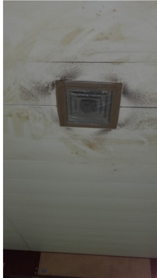
Figure 30 : Traces prononcées de poussières au niveau de bouches de soufflage
