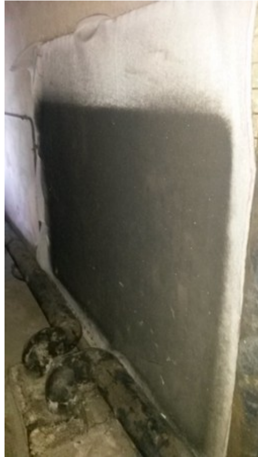
Figure 20 : Pré-filtre fortement encrassé dans le Plénum d'air neuf AN3
