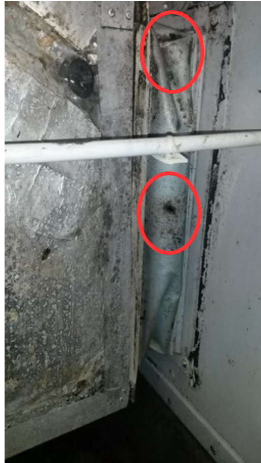
Figure 22 : Raccordement entre la manchette souple du raccordement CTA AE /gaine de ventilation percée
