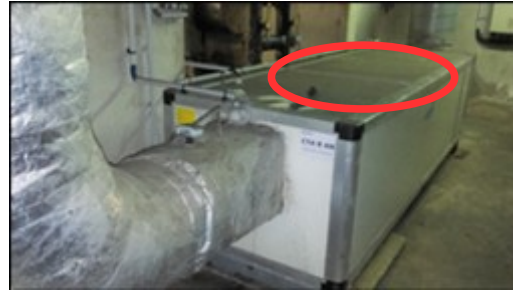
Figure 14 : Présence de suie sur CTA (CTA R AN)
