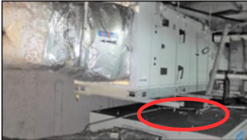
Figure 13 : Présence de suie sur CTA (CTA BB et BC)
