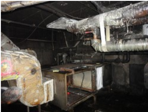
Figure 3 : Anciennes CTA qui n'ont pas été déposées avant l'incendie
