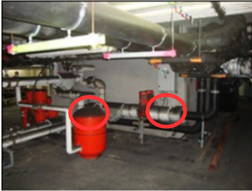
Figure 15 : Présence de suie sur équipements
