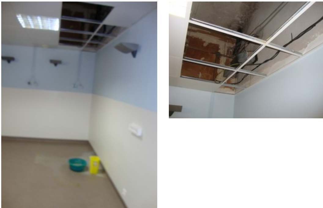
Figure 23 : Fuite d'eau au niveau du plancher haut dans le service des Urgences
