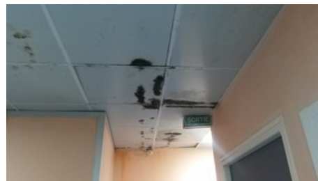
Figure 35 : Moisissures et rouilles dans les dalles de faux plafond
