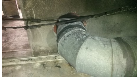
Figure 5 : Conduit d'extraction vers le plénum non étanche
