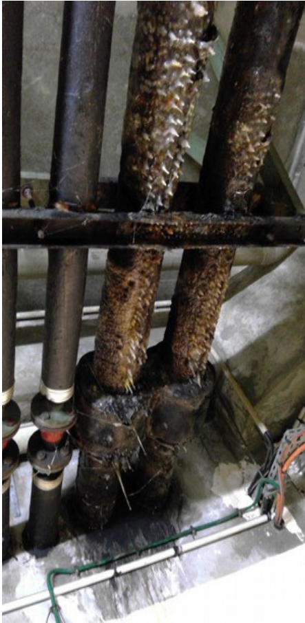
Figure 34 : État des canalisations du réseau d'eau glacée
