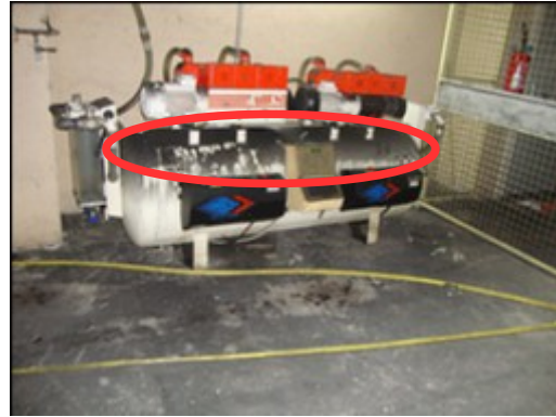
Figure 16 : Présence de suie sur équipements
