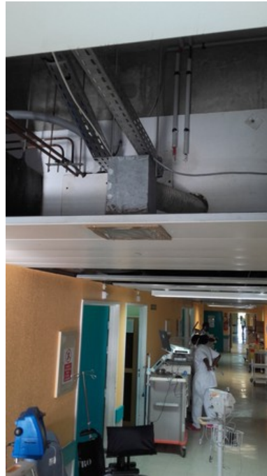
Figure 28 : Calfeutrement d'une bouche de reprise
